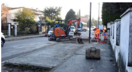
Fibra Ottica Cantiere in via Alighieri DIENNE FOTO
